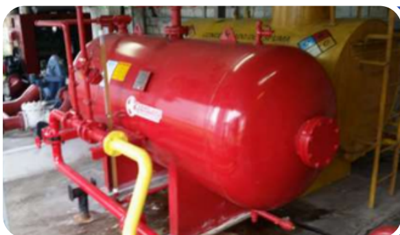
MONTAJE DE TANQUE DE ESPUMA PARA SCI PLANTA DE VENTA IQUITOS
