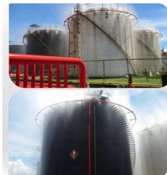
MONTAJE DE TUBERÍAS DE ACERO Y HDPE PARA PROYECTO PRUEBA DE SCI – ANILLOS DE ENFRIAMIENTO PARA TANQUE DE ALMACENAMIENTO PLANTA DE VENTAS EQUITOS
