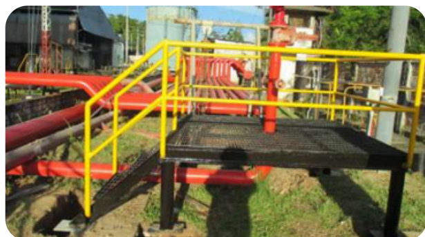
PREFABRICADO DE ESTRUCTURA, MONTAJE DE LÍNEA Y MONITOR PARA SISTEMA CONTRAINCENDIO PLANTA DE VENTA IQUITOS
